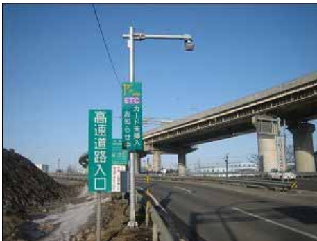
〈カード未挿入お知らせアンテナの設置状況〉 道央道 札幌IC
