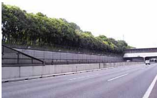
《遮音壁設置状況》 常磐自動車道（流山IC～柏IC）
