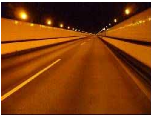
《従来のナトリウム照明》 関越道 関越トンネル
