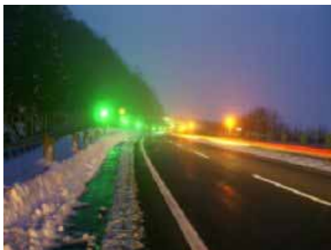
(自発光式視線誘導標の点灯状況) 道央道 旭川管内
