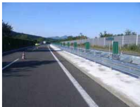
《強化型中分防護柵(整備後)》
