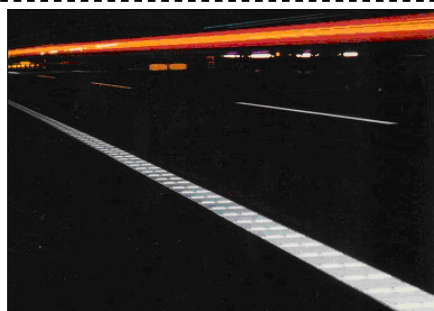
《夜間事故対策の高視認性区画線》
