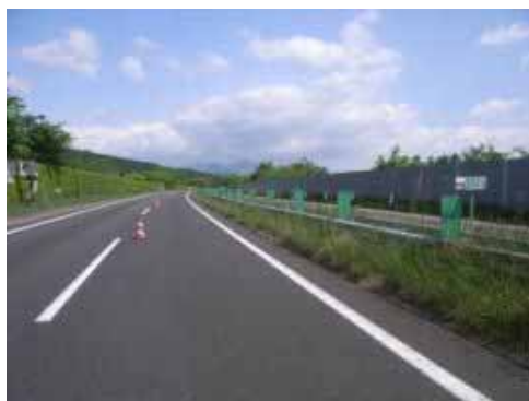
《中分防護柵(整備前)》
