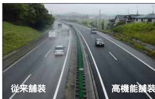
(雨天時における高機能舗装と通常舗装の状況)
