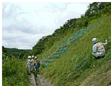
(のり面の点検) 上信越道 吉井IC～富岡IC間
